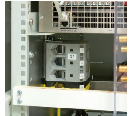
Входной терминал AC / AC input terminal
