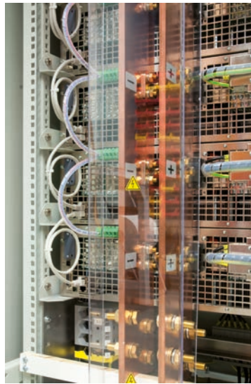
Шина терминалов DC / DC bus terminal
