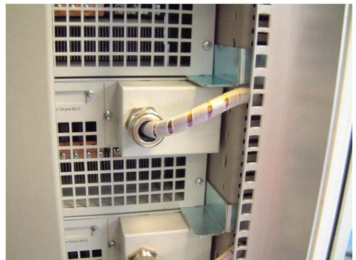
Bild 1: Netzanschluß Einzelgerät (Abb. ähnlich)
