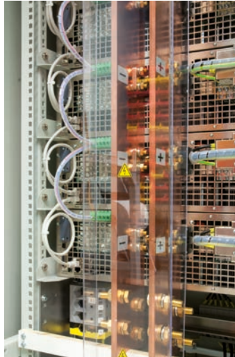
直流总线端 / DC bus terminal
