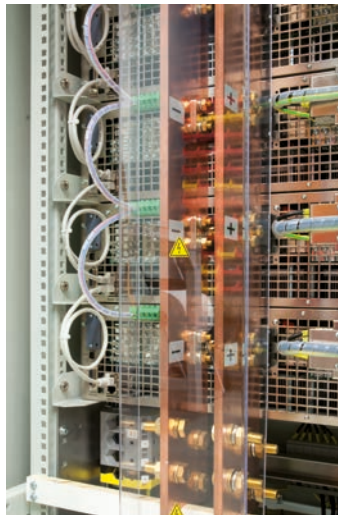
DC-Anschluß / DC bus terminal
