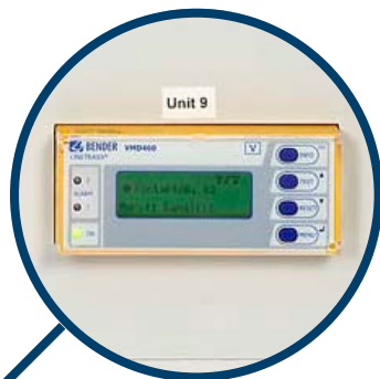
监控装置 (回馈系统的可选电网保护装置)
