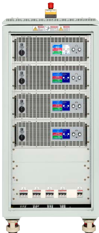
24 U机柜装配完前视图
