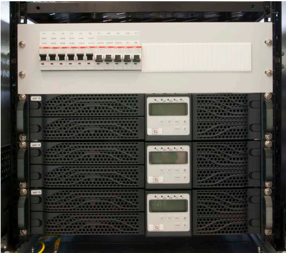
Bild 6. Sicherungen &amp; USV-Gerät mit Bedienteil
