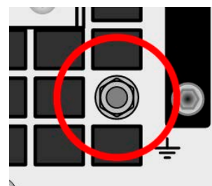
Figure 13 - Point de mise à la terre
