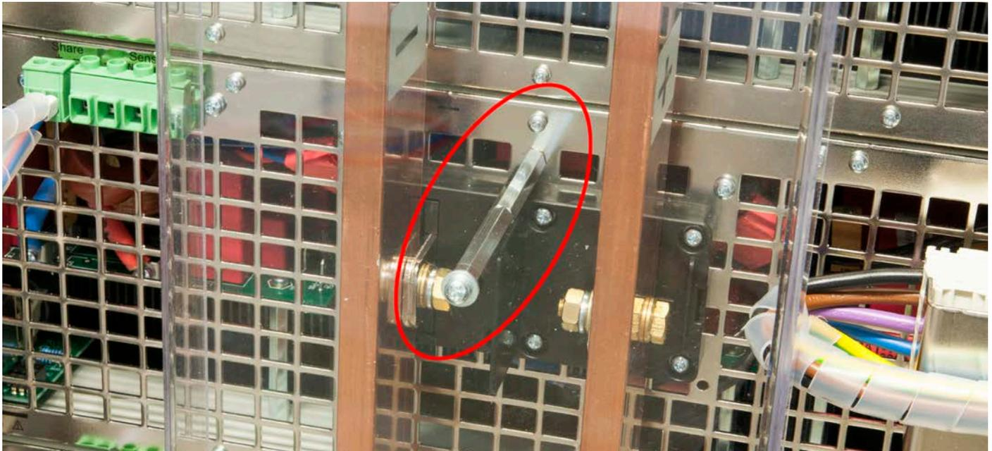
Abb. 6 - Sechskantbolzen, Montageposition
