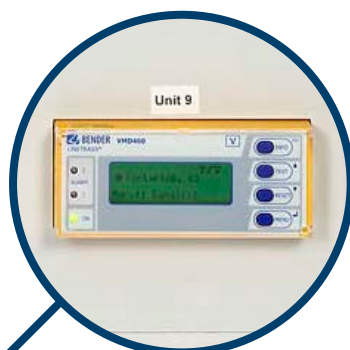
Устройство наблюдения (опциональная защита электросети для реверсивных систем)
